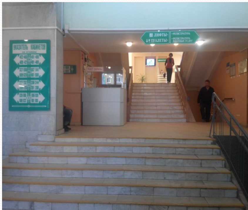
До проведения ремонта
